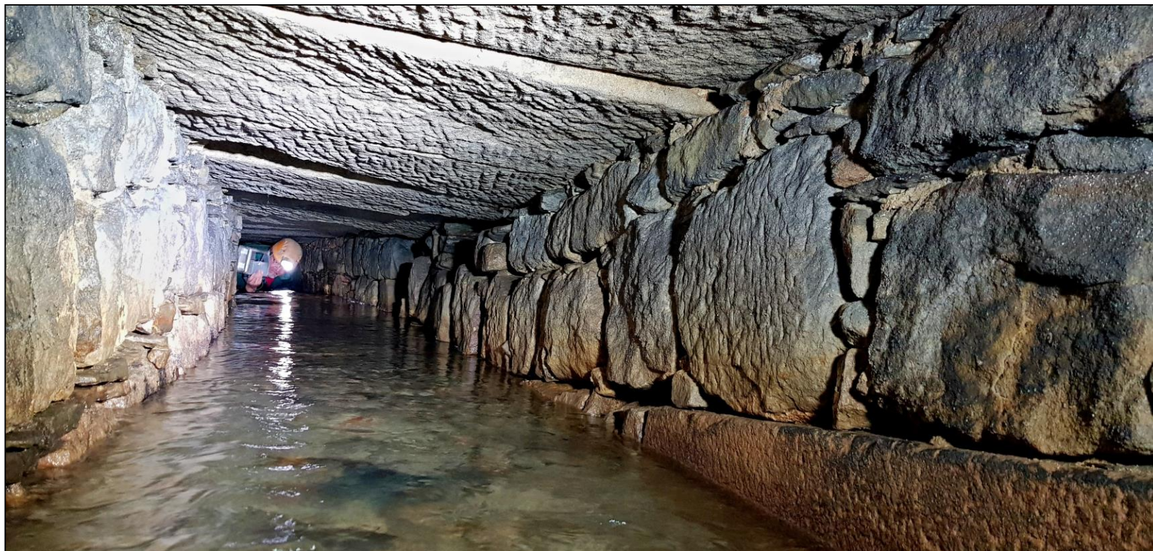
Zanesená štola (standardně 130 cm vysoká) vlivem poškození pod silnicí
